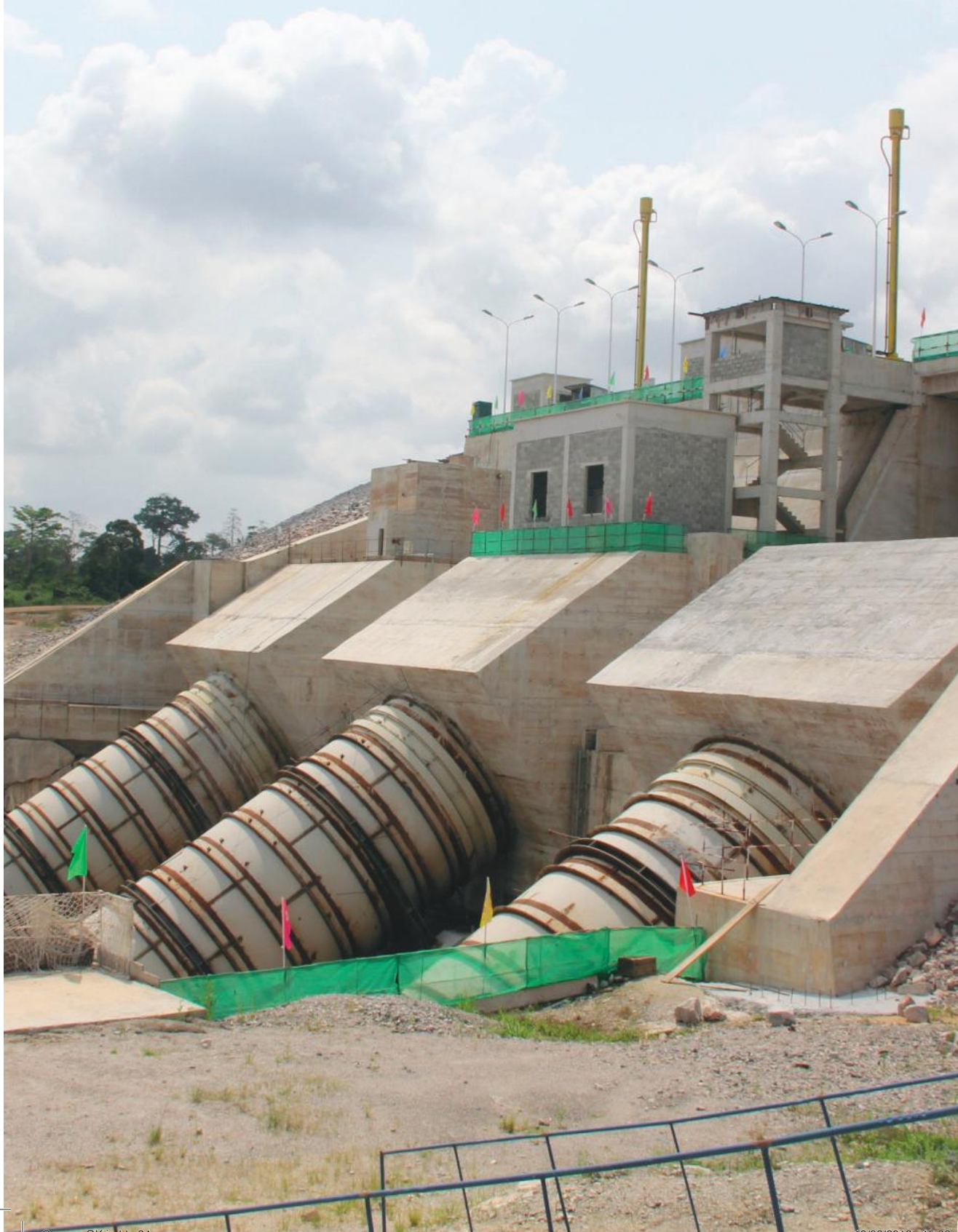
Barrage de SOUBRE (Côte d'Ivoire)
