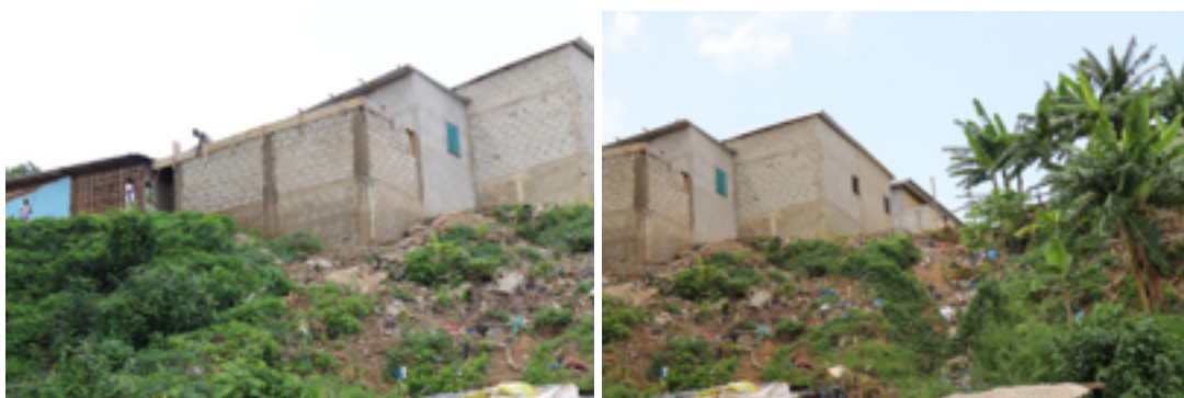
Figure 4 : Malgré le danger apparent, les populations continuent de construire des maisons dans des zones dangereuses. (Cocody Colombie).
